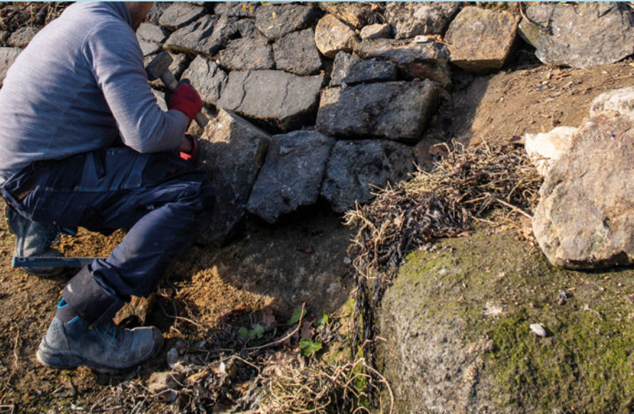
Travaux de restauration du perré par l'entreprise Marc sur la voie du Youtar.
