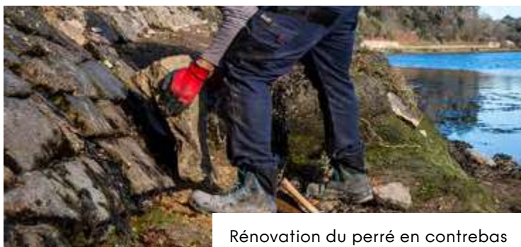
Perré le long du Goyen
