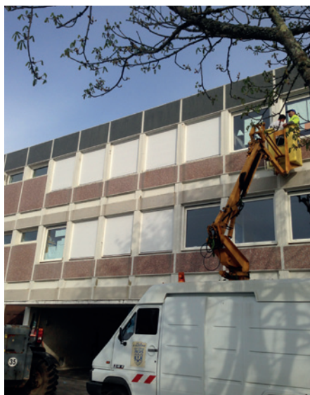
Travaux façade école
