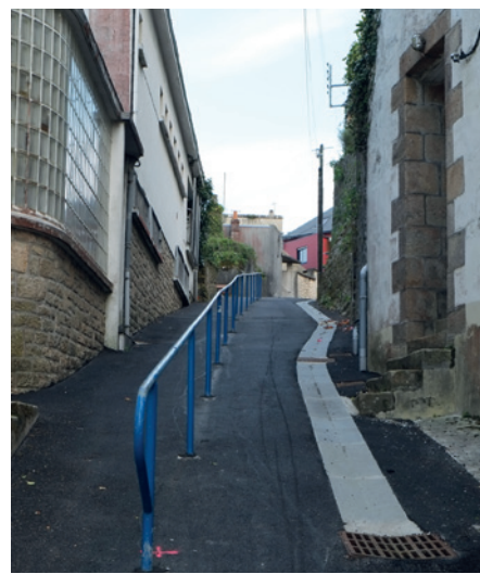
Réfection de la rampe
