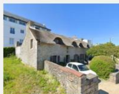
Maison à toit de chaume
