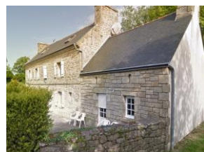
Maison en pierre, Village de Kerboul
