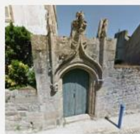
Porte en accolade
