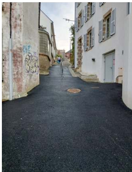
Travaux d'enfouissement rue Carnot.
